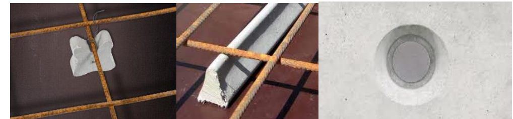
2017: Asbesth. Abstandhalter + Mauerstärken im Betonbau
