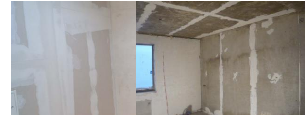
Asbesth. Spachtelmassen + Putze
